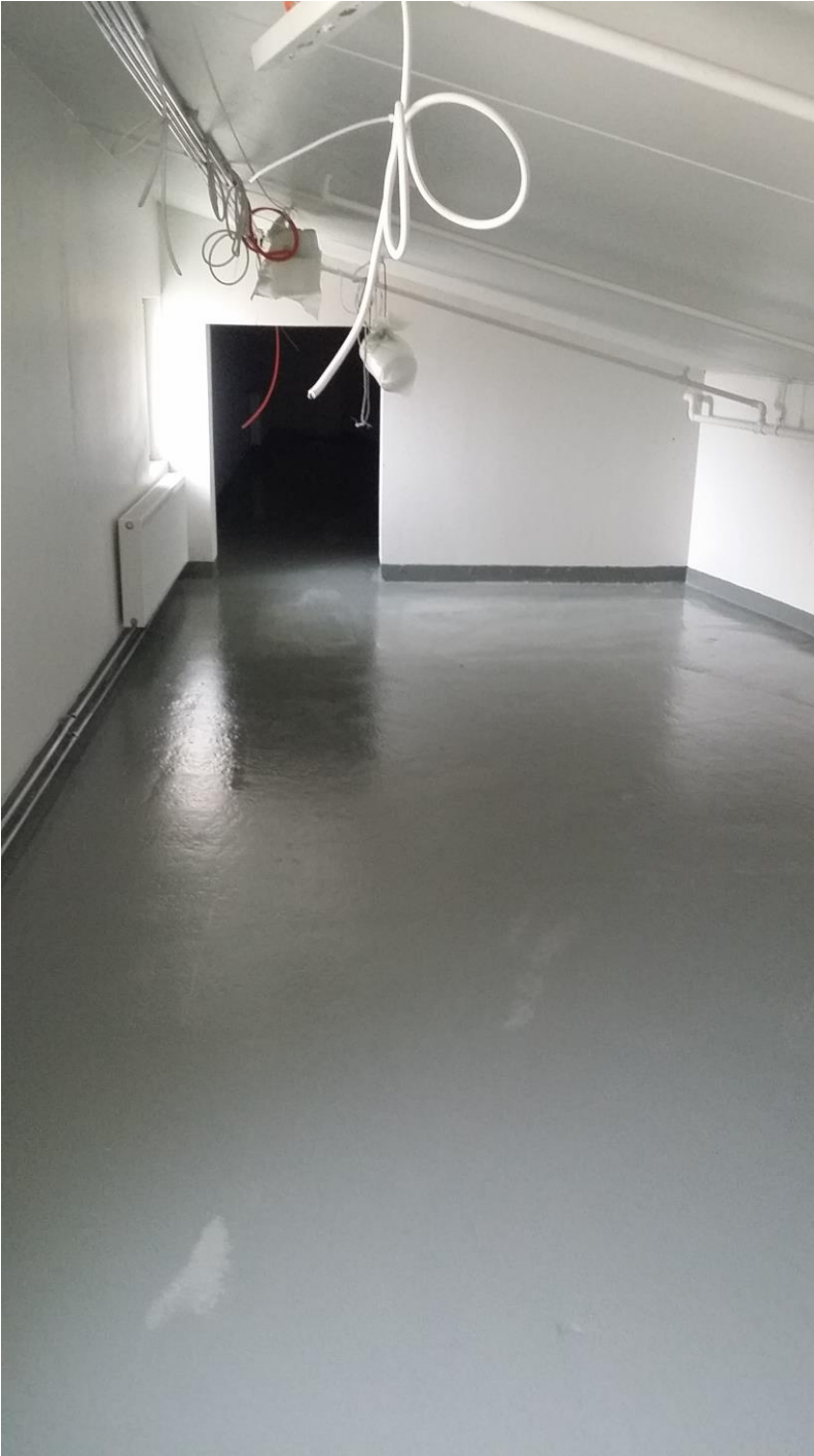
Ullakon varastotilan takaosan juuri maalattu lattia.
