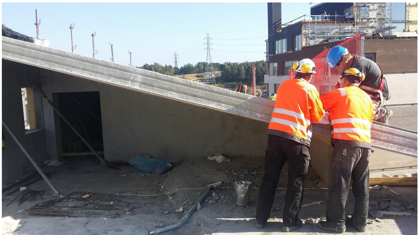
Jari ja Olli ohjeistamassa vaativaa asennusta. Asentajalla kiipeilyvaljaat päällä.
