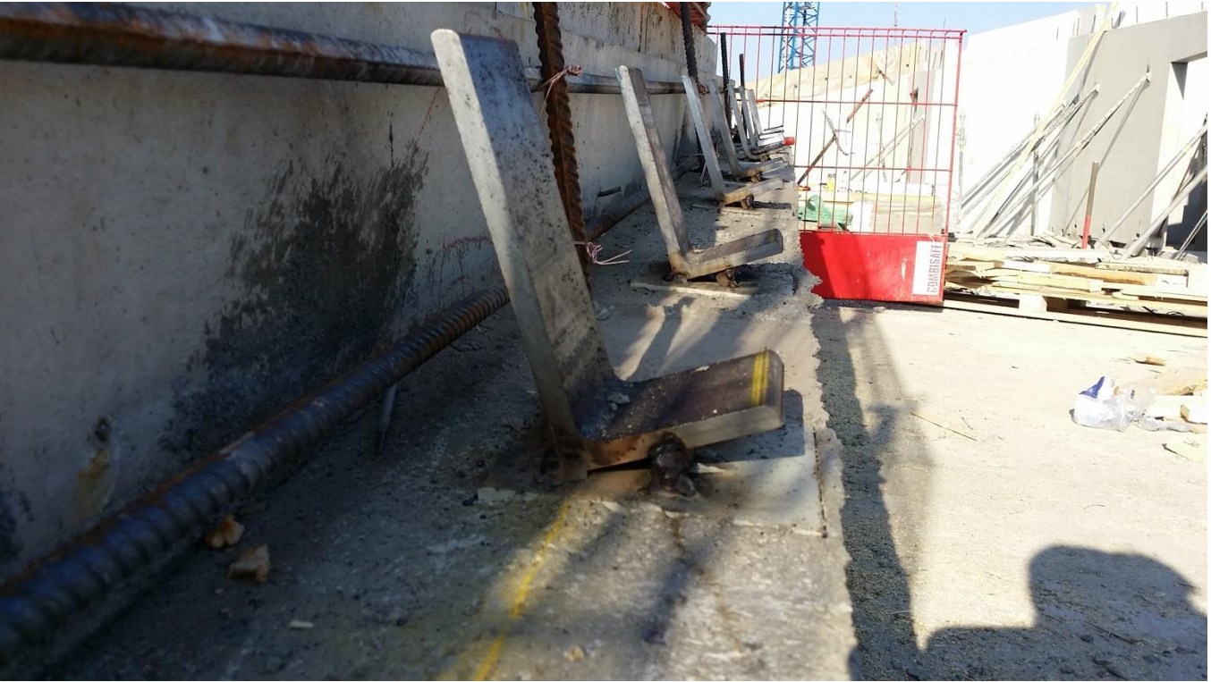
Vinon ontelolaattayläpohjan asennustukia odottamassa elementtejä.
