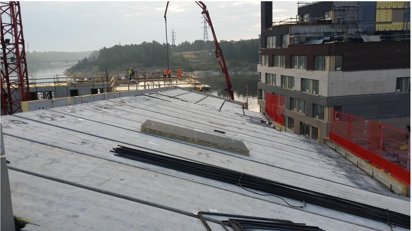
Yläpohjan elementit paikallaan.
