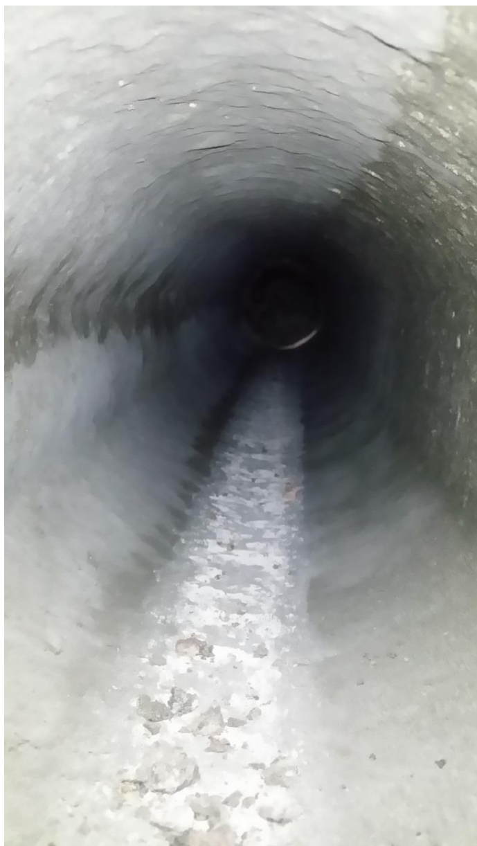
Välipohjien ontelolaattoja sisäpuolelta kuvattuna.
