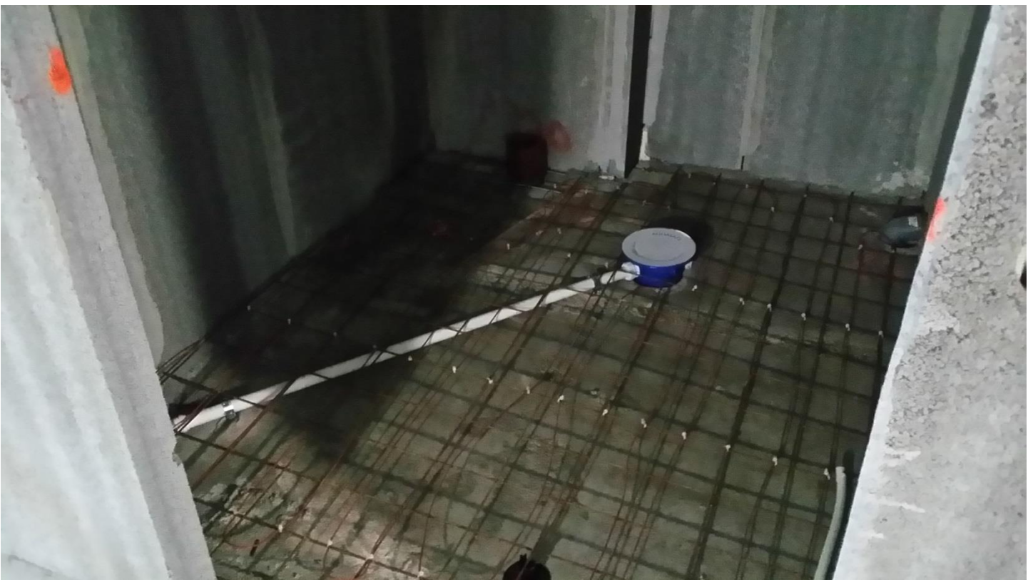
Lattialämmitys ja muuta valuun jäävää tavaraa
