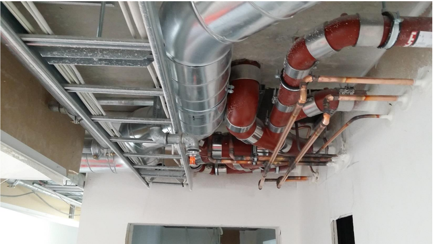
Asentajien taidonnäyte, ahdasta on. Palokatkot putkien juuressa (valkoinen mössö).
